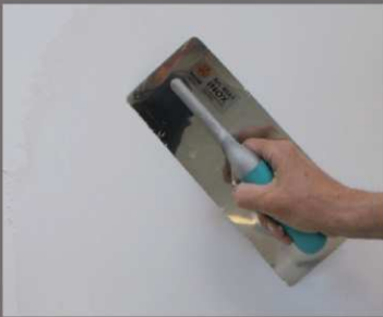
Rasatura con Plastuc Tipo A Levelling with Plastuc Tipo A
